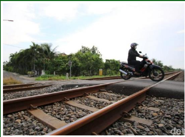
Perlindungan tanpa palang pintu atau tidak terjaga
